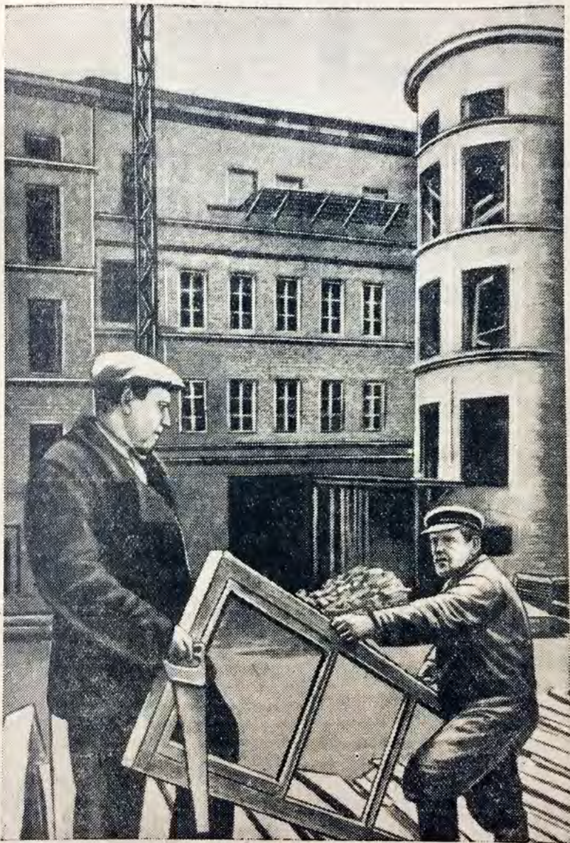
Строительство школы по улице Маяковского, 9. На переднем плане снимка — бригадир плотников Н. Панкратьев (слева) и столяр А. Кокорев
